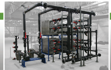
Assemblage terminé en 9 heures
